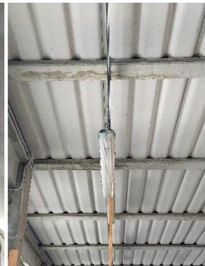
*15. Particolari struttura: travi-pilastrati e tamponamenti prefabbricata in c.a.*
